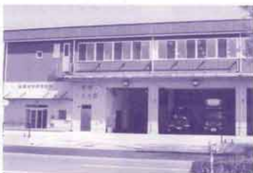
消防救急デジタル無線整備の予算がついた(写真は4月1日にスタートした南消防署)
