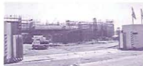
▲写真は(仮称)田迎小学校分離新設校舎新築工事(4月4日撮影)
