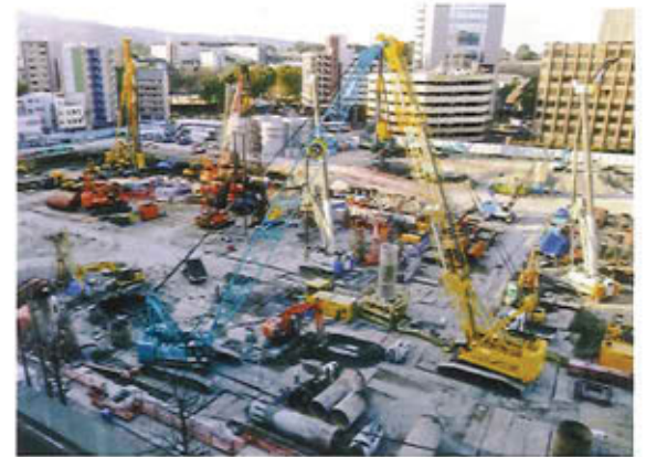
▲県民百貨店などの跡地は桜町地区再開発事業の工事がスタートした。
