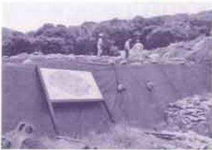
熊本市西区池上町にある1200年前に存在した池辺寺跡(史跡)は「池辺寺歴史公園」として工事がスタートした。
