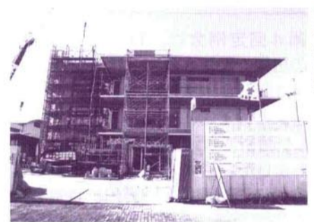
西区の区役所の建設工事も着々と進んでいます
